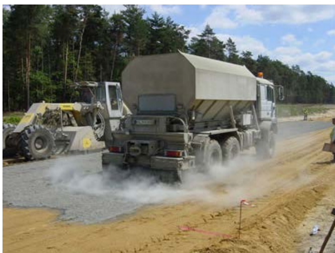
Rozkładarka spoiwa i gruntomieszarka
