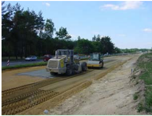
Gruntomieszarka i walec
