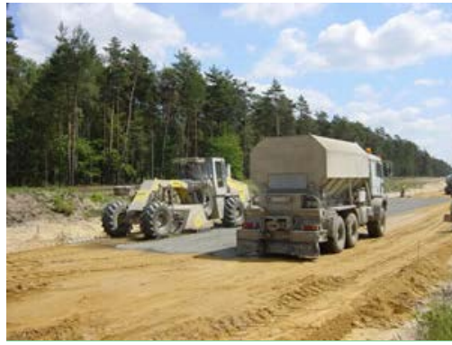
Rozkładarka spoiwa Man i gruntomieszarka
